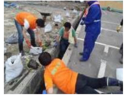
写真上：側溝に詰まったヘドロを取り除いています）
